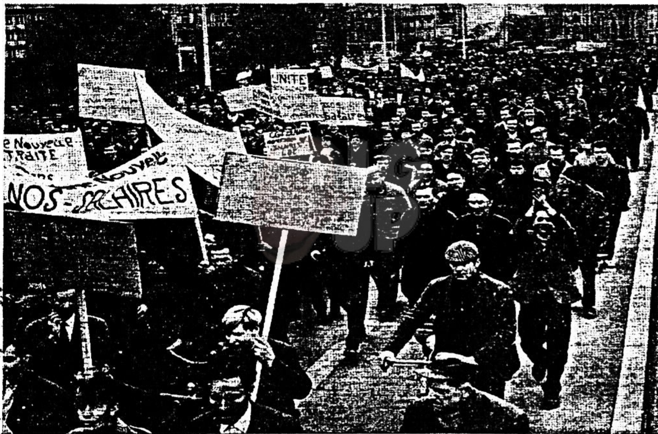
Une partie du défilé sur le pont de la Victoire
